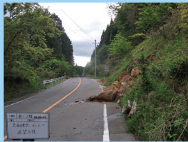
町道奥三河線 法面崩落箇所
